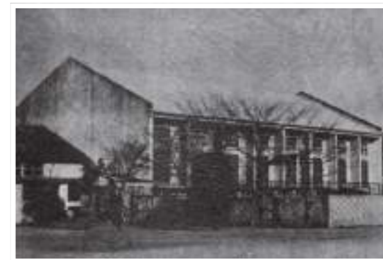
体育館写真(30年史より)
